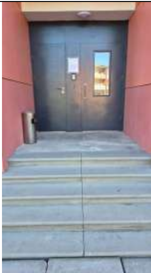
Kāpņu telpas ārdurvis
